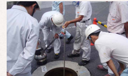
岡山工場における有害物質漏洩を想定した排水管閉止手順確認訓練の様子
