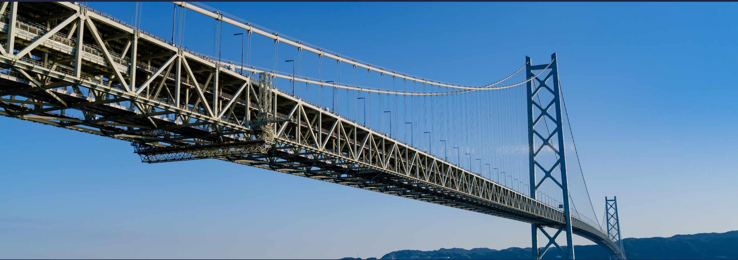
明石海峡大橋
