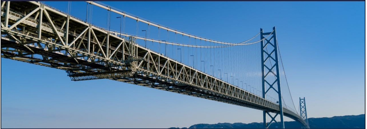
明石海峡大橋
