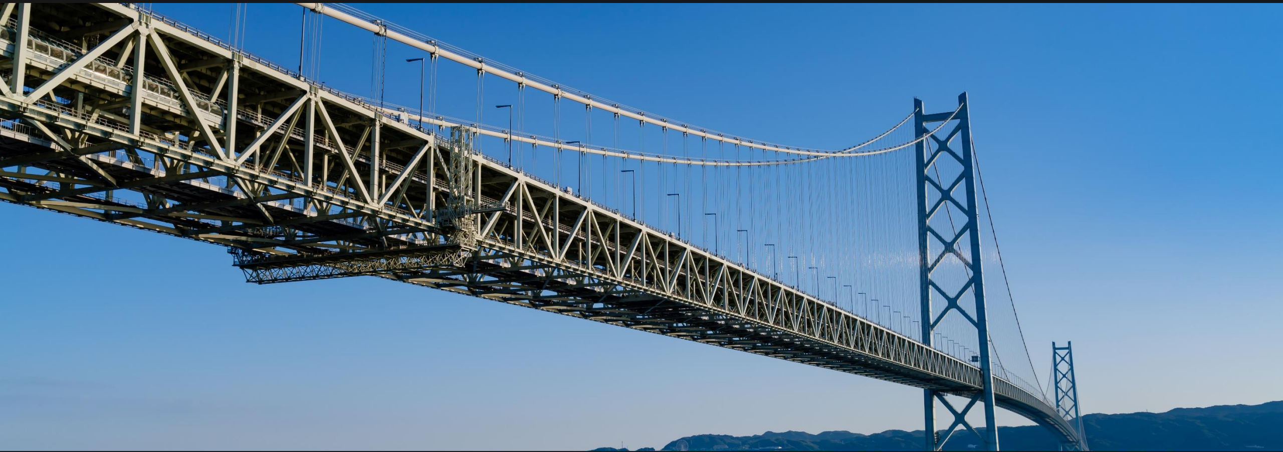
明石海峡大橋
