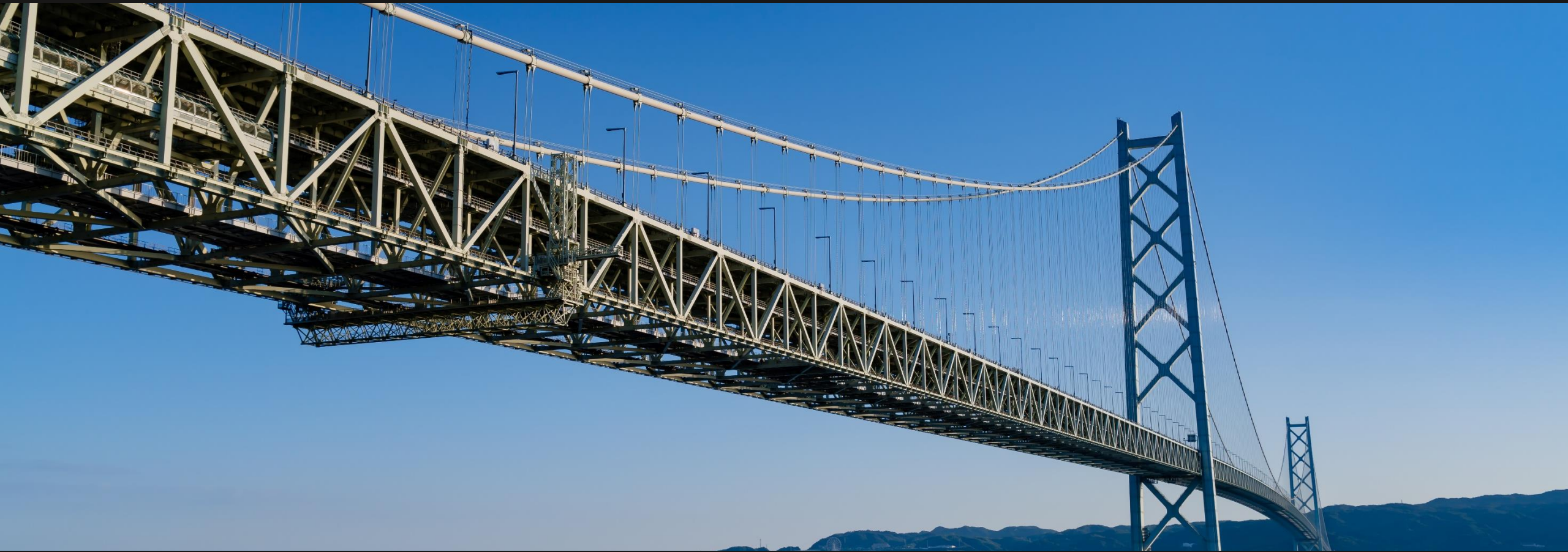
明石海峡大橋
