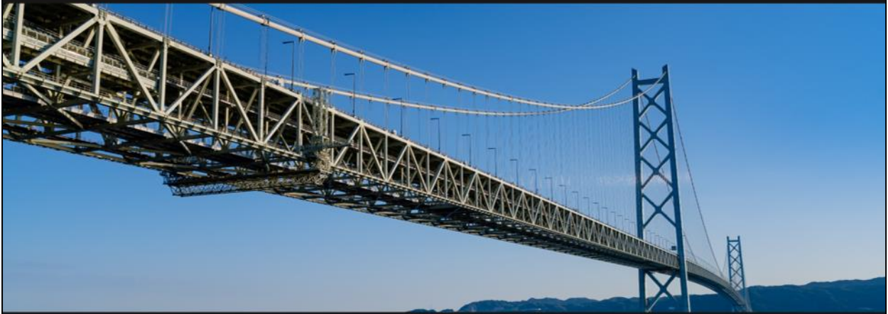
明石海峡大橋
