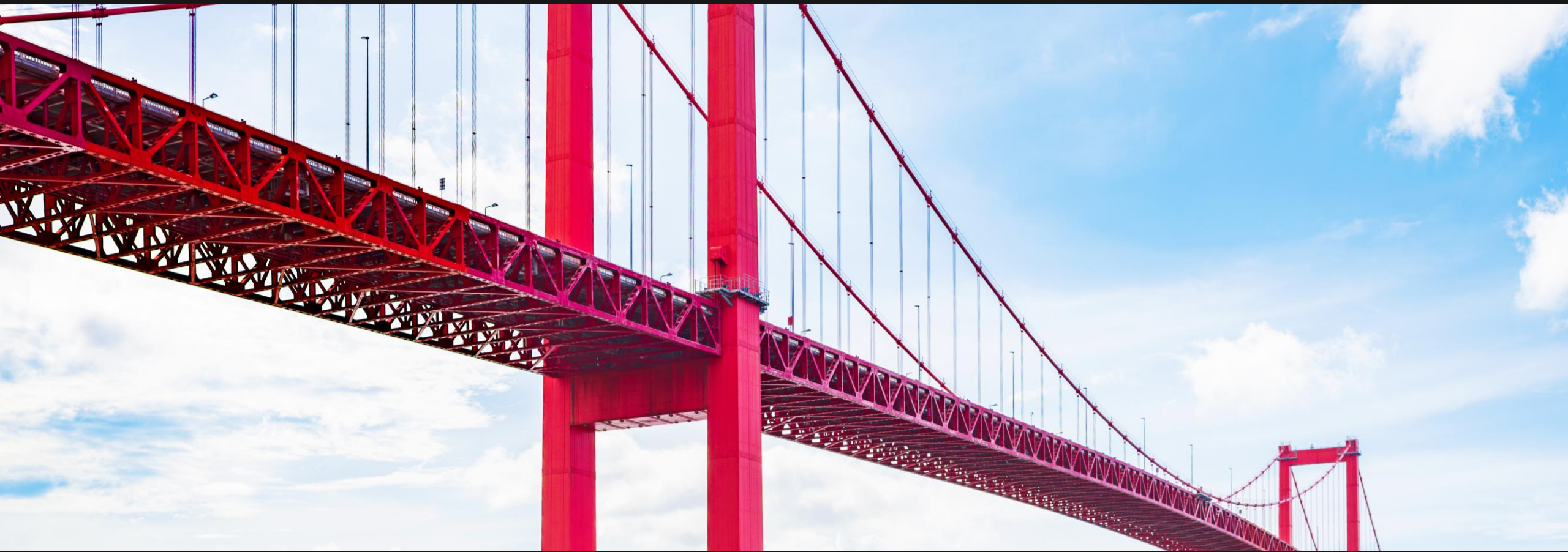
若戸大橋 (国指定重要文化財)
