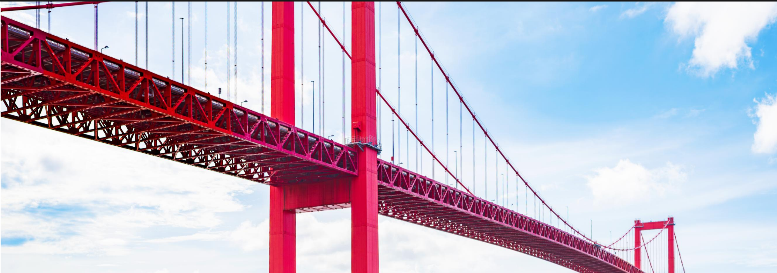
若戸大橋 (国指定重要文化財)
