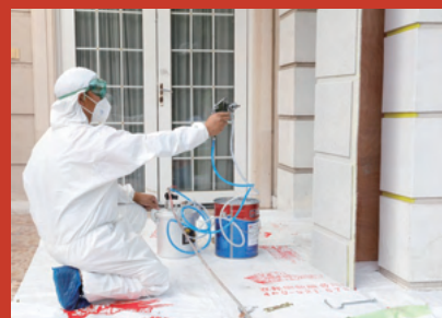
「リフレッシュ」サービス：外壁への吹き付け塗装
