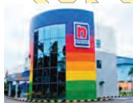
塗料メーカーらしく彩られた日本ペイント・マレーシア本社ビル。
