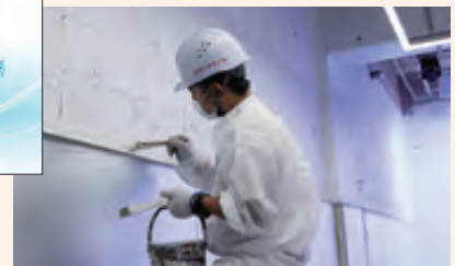
ダンススタジオ「in the house」の塗装現場
