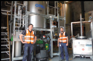
溶剤回収プラント
