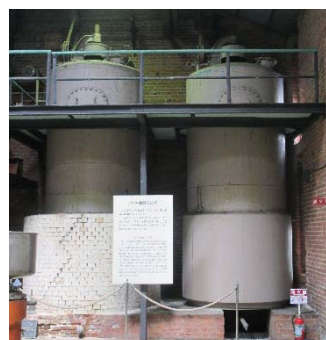
ボイル油製造設備
